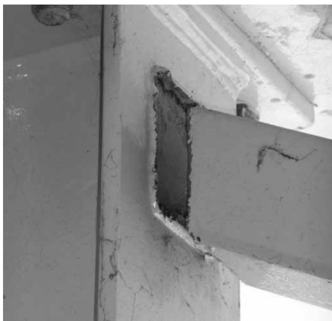
(c) and (d) Fractured non-ductile brace-to-column connection
