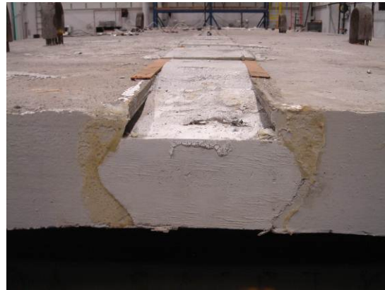
(d) Under fill at the end of girder
