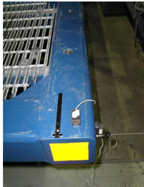
(d) SE Corner
