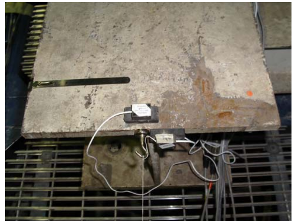
(d) SE Corner
